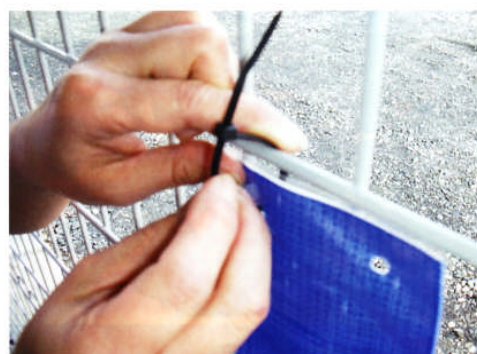
③ 取付けバンドを2箇所に差し込みます。一度取り付けたバンドは外すことが出来ません。
