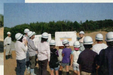
調整池の工事現場も見ました
